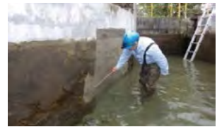
湿潤面補修材の試験施工の様子(東長原事業所 旭ダム系水路の壁面補修)
