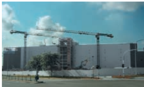
建設中のシンガポール新工場
